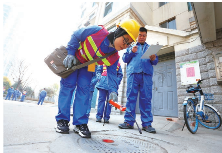
▲ 济宁公司安全巡线员开展安全巡线工作
