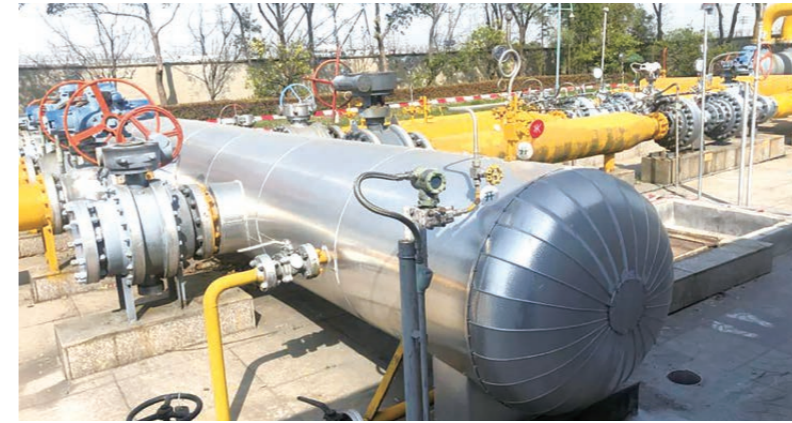
▲ 长兴公司长兴门站噪音治理项目现场
