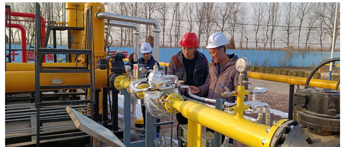
> 青岛公司实施门站设施改造，提升区域保供能力
