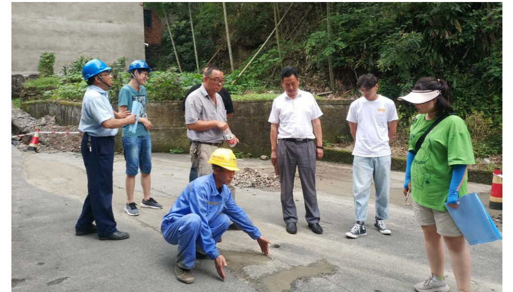
> 富阳公司开展振兴乡村燃气建设
