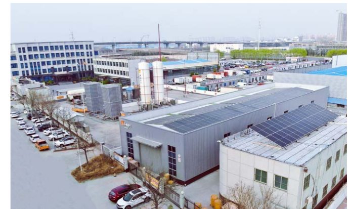
> 临沂公司仓库分布式光伏项目
