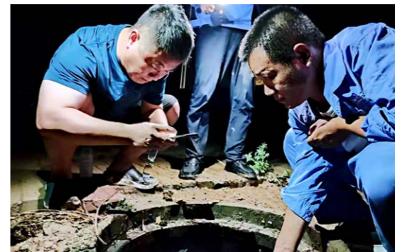
> 安阳区域汤阴公司现场指挥抢修抢险
